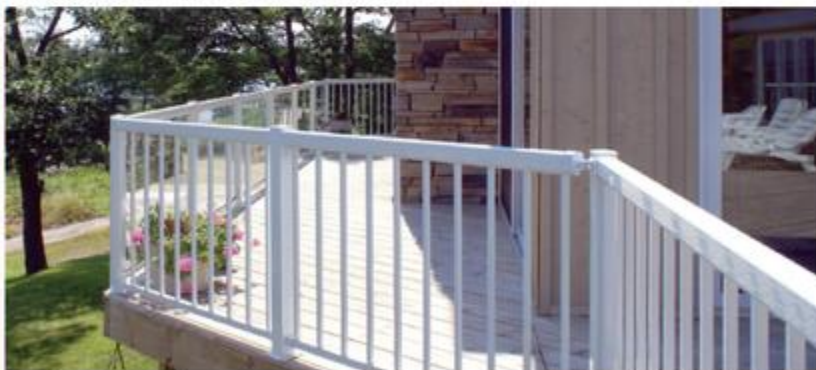
Garde-corps en piquets blancs White picket railing
